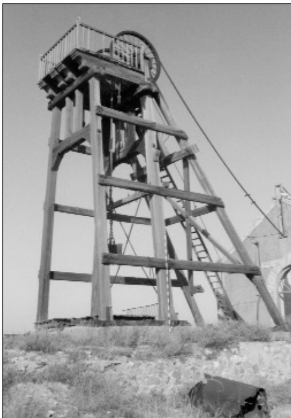
Figura 1.- Castillete de madera de seis patas de la Mina María Jesús. Conjunto de la periferia del Cabezo Rajao.
