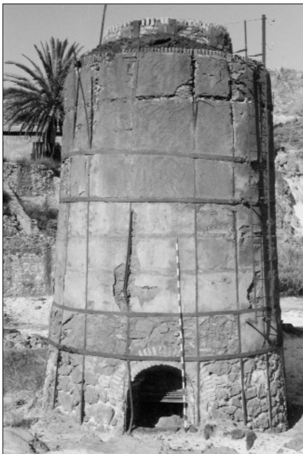
Figura 3.- Horno de calcinación de manganeso mina San Francisco Javier. Conjunto de la Rambla del Avenque.
